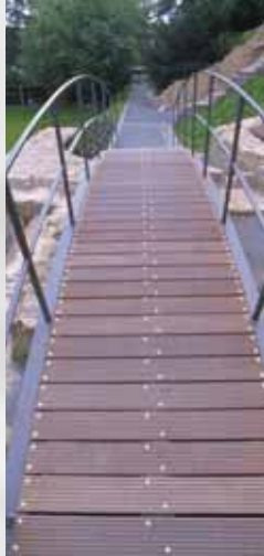
Eine elegante Rundbogenbrücke spannt sich über die Reste des Torwächterhauses bis hin zur kleinen Kasematte.
