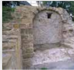
Die kleine Kasematte, ein Schutzraum gegen Beschuss feindlicher Truppen, war ursprünglich fast vollständig mit Erde bedeckt.
