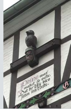
Hausfassade am Marktplatz Peine.
